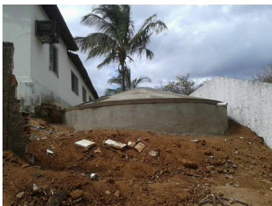
RETIRADA DE ENTULHOS E ENTORNO DA CISTERNA
