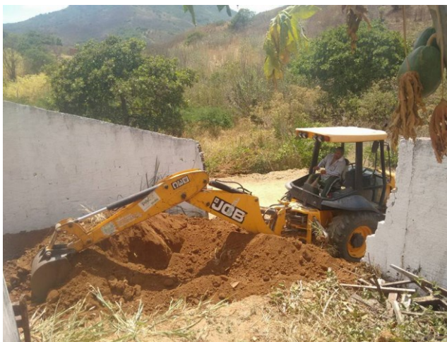
CONSTRUÇÃO E MONTAGEM DA CISTENA ESCOLA EEB JOSÉ EDILSON DE SOUSA
