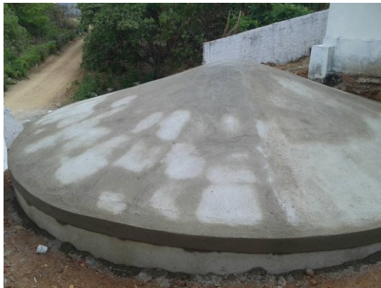
ACABAMENTO E PREPARAÇÃO DA CISTERNA
