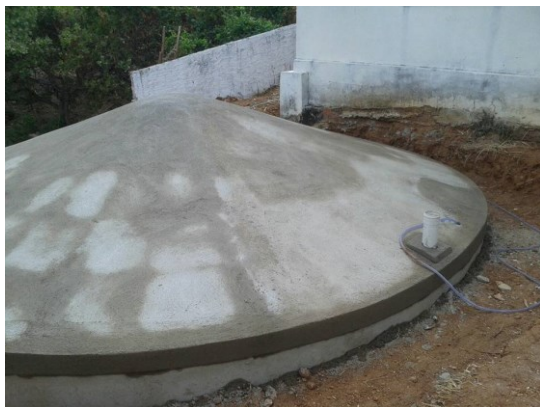
REPOUSO E FINALIZAÇÃO DA CISTERNA
