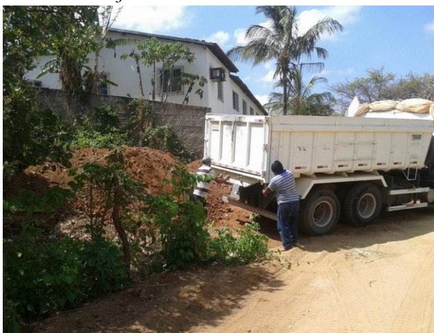
DEPÓSITO DE MATERIAL PARA CONSTRUÇÃO DA CISTERNA
